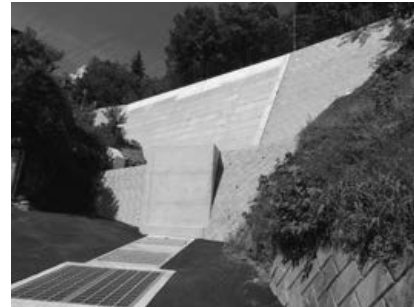
改修が完了した国道崩落現場
